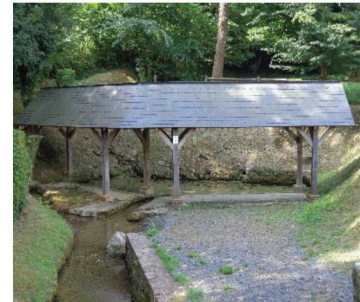
Lavoir – route de Cambremer
