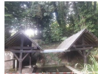
Lavoir chemin des Querrières
