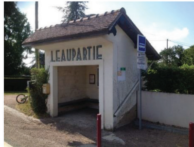
Abri de bus typique de la Reconstruction après Guerre
