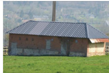
Ancien bâtiment de ferme, Chemin de Campelou, B13
