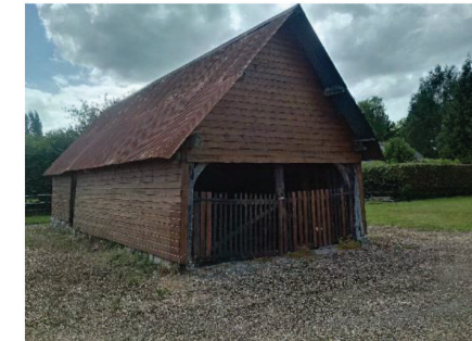
Ancien bâtiment agricole, Ch de Roncheville, A490
