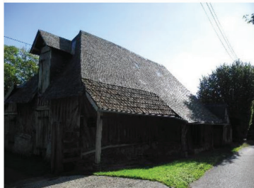
Dépendance, 1561 Chemin des fontaine, A432
