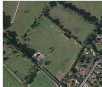
Ancien bâtiment agricole, Chemin Neuf, B467
