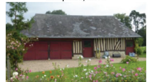
Annexe, D58 – route de Saint Martin, 254
