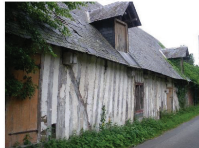
Ancien bâtiment agricole, Ch de Roncheville, A441
