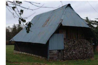
Ancien hangar, Le Lieu Gosset - 484 Chemin des Maureys, D545
