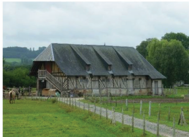
Ancien bâtiment agricole, Basse Rue, A556
