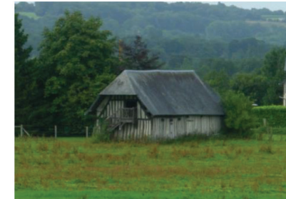
Ancien bâtiment agricole, Basse Rue, A157/158
