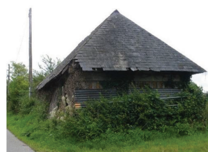
Ancien bâtiment agricole, Ch de Roncheville, A445
