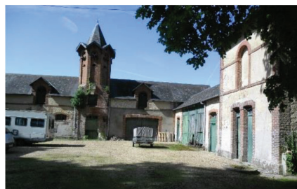
Dépendance, route de Lisieux, C209
