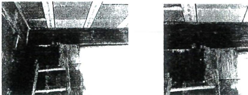
Un sondage en tête au niveau du linteau me permet de constater la présence de béton dans la brique coffrante.
