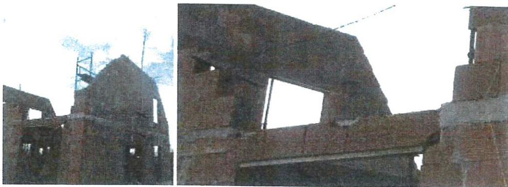
Au 1<sup>er</sup> étage, le rampannage des pignons n'a pas été réalisé.
