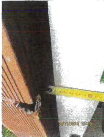
Sur les 2 portes fenêtres côté accès au terrain, nous relevons un appui des linteaux sur la maçonnerie courante voisin de 10 cm.
