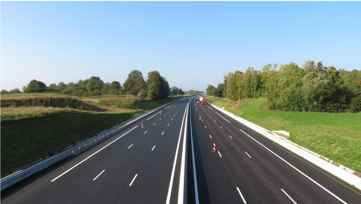
Figure 3 : Vue sur l'A13 en direction de Paris depuis l'ouvrage de la Haie Tondue (octobre 2021)
